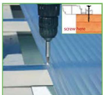
8) Jak je patrné z obrázku, panely se šroubuji na každý příčný nosník. Pro přivevňování použijte vždy originální **Guttagliss Easy Click** šrouby! Jejich speciální dyzajn zajišťuje funkčnost a dokonalé utěsnění. Zašroubování provedte v místě viz. obrázek a utahuje do chvíle, kdy se projví jemná deformace panelu.
