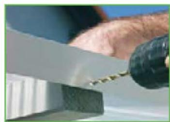
6) Připevněte hliníkový profil ke každému příčnému nosníku. Vyvrťte 4mm díru tak, aby se daly umístit podložky a nevykukovaly zpod porofilu. Pozor ať nevyvrátíte díru příliš vysoko.
