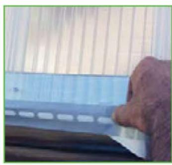
12) Na vrchní hrani, která přiléhá ke stěně, použijte Guttaband ventilační pásku. Tato zabrání vnikání nečistot a hmyzu, ale je přitom prodyšná a odvětrává případnou vlhkost z komůrek.
