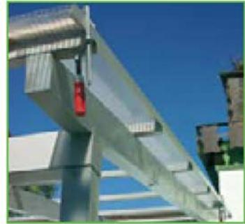
5) Nyní zatlačte připravené panely do hliníkových profilů tak, aby se seříznuté plochy zámků dotýkaly po celé délce uvnitř profilu. První díl je nyní umístěn na konstrukci, pečlivě na nosníky, **po směru stékání vody!** - zarovnaný a upěněný svorkami. Na straně musí hliníkový profil dostatečně přečnívat přez nosník (odkapávání vody), použijte minimálně dvě podložky viz. obrázek. Tyto podložky rovněž použijte k vyrovnání případných rozdílů v délce nosníků.
