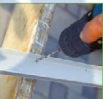
11) Zařízněte poslední profil na potřebnou délku, nezapomeňte na správné úhyly seříznutí. Vyrtejte řadu 3mm dírek po 10 cm zespodu ukončovacího profilu viz. obrázek. Zlepší se tím větrání případné kondenzace.
