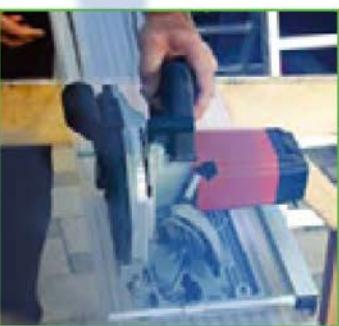
10) Zařízněte poslední panel na potřebnou délku - při počítání vezměte v potaz přesah potřebný pro zasunutí do hliníkového profilu. Zavakněte poslední panel a nasuňte hliníkový profil, který jste si předtím připravili a uřízli. Přišroubujte profil stejně jako je popsáno v bodě 6.
