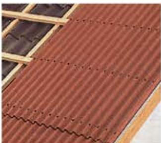
Systém Gutta používá speciální hřeby se samotěsnící trvale pružnou PE hlavou zabraňující vniknutí vody a tvorbě ledu pod hlavou hřebu.
