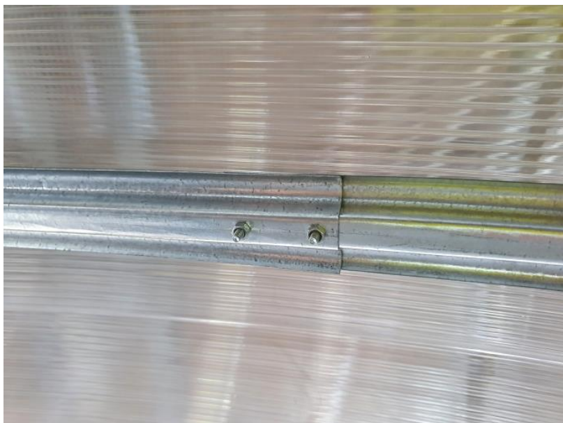
pohled z vnitřní strany skleníku na detail 1
