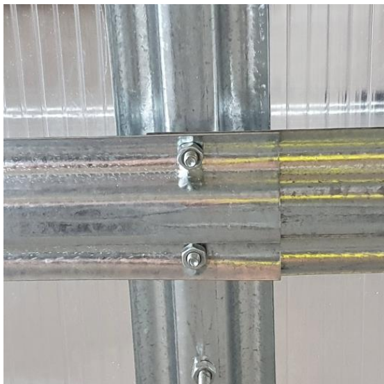
detail F (pohled zevnitř skleníku)
