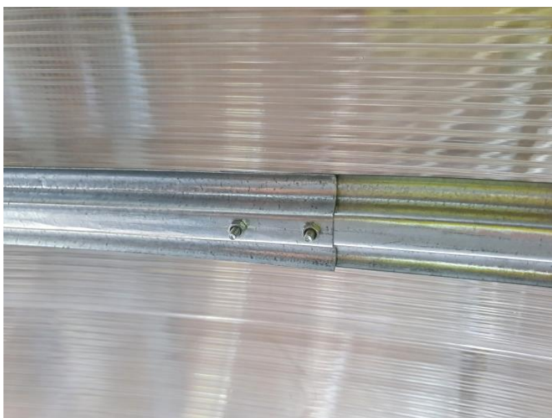
pohled z vnitřní strany skleníku na detail 1
